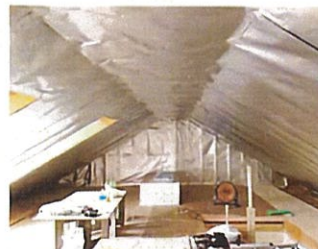
木造の小屋裏部屋へ!
