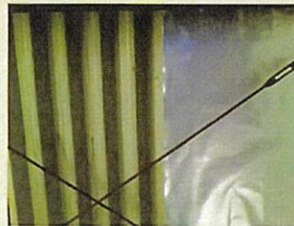
屋根下遮熱 左側なし 右側施工あり
